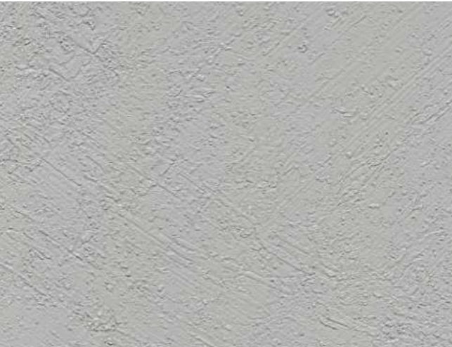
텍스처 콘크리트 TEXTURE CONCRETE CR 200
